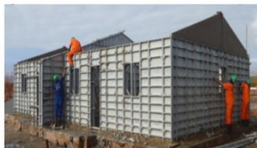
Método Construtivo em Concreto Celular Espumoso Fonte: O GLOBO
