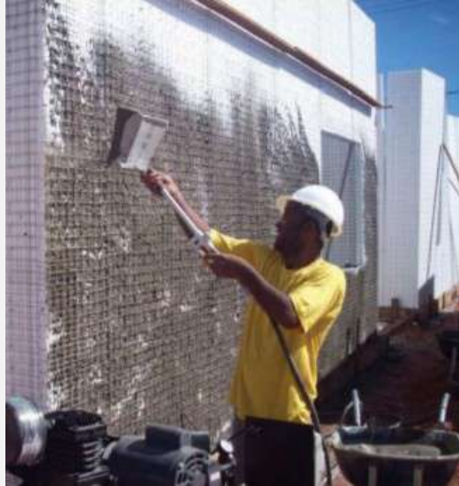
Figura 10 – Projeção da argamassa 1º camada.
