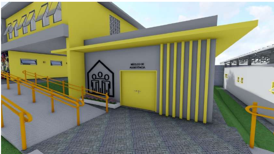
Imagem 30 – Fachada do Nucleo de Assistência
