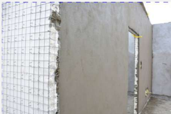
Figura 11 – Aplicação da 2º camada.
