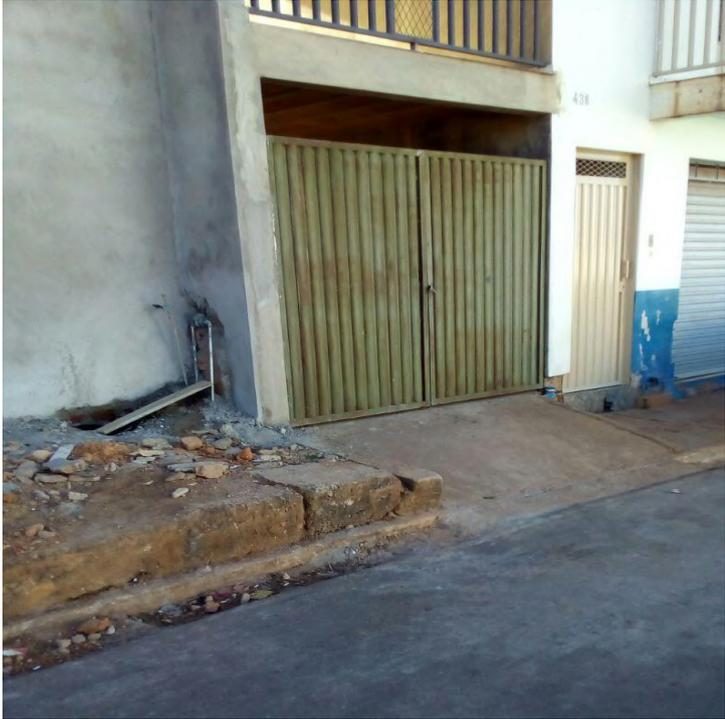
Figura 12 – Calçada com degrau, rampa inadequada e entulho. Fonte: Pesquisa direta.
