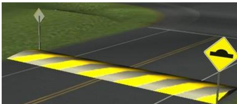
**FIGURA 3** - Sinalização vertical e horizontal em lombada tipo I. Fonte: Portal de Interlagos.
