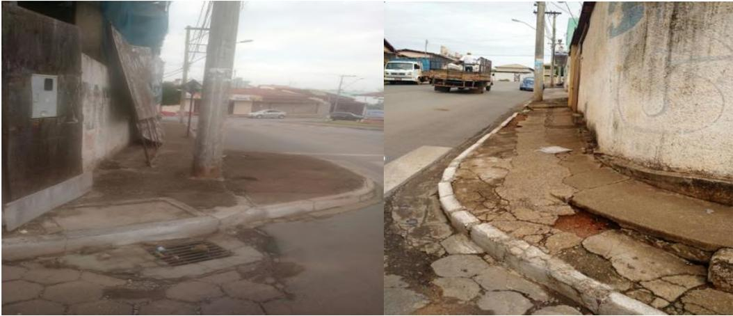
Figura 8 – Calçada esburacada. Figura 9 – Ausência de rampas para cadeirantes. Fonte: Pesquisa direta
