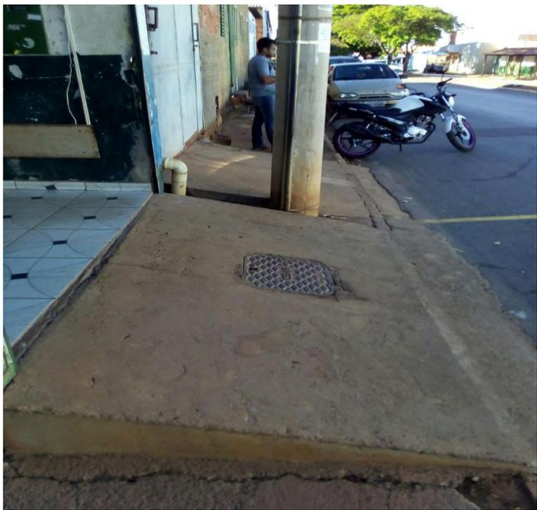
Figura 10 – Calçada com rampas inadequadas e sem vão livre mínimo.
