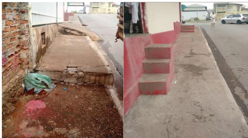
**Figura 1** – Ausência de rampa de acesso. **Figura 2** Obstáculos na calçada. **Fontes:** do autor
