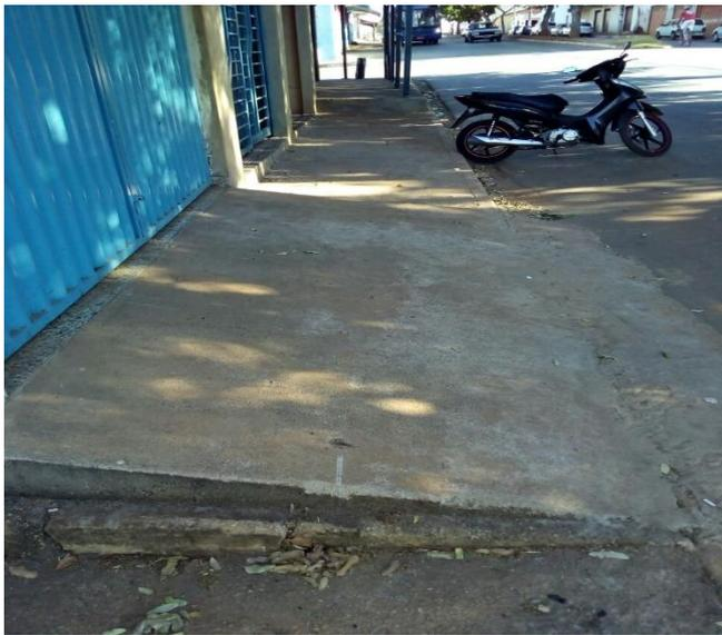
Figura 06 – Rampa inadequada.Fonte: o autor
