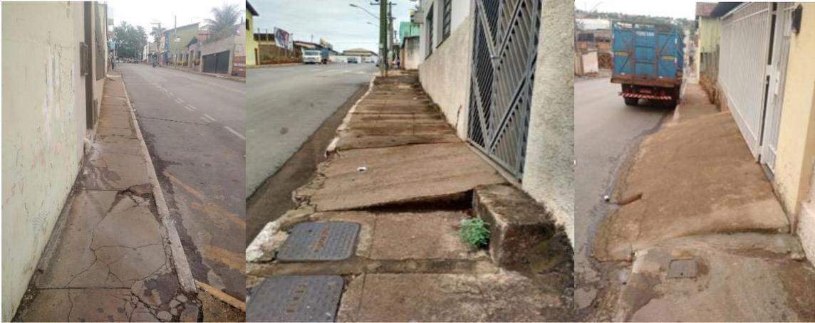
Figura 5 – Calçadas irregulares. Figura 6 – Rampas de garagem no meio da calçada. Figura 7 – Rampa daclínica. Fonte: Pesquisa direta
