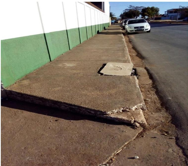
Figura 11 – Melhor trecho de calçadas estudado, apresentando: vão livre mínimo, e trecho livre de obstruções, porém não possui rampa de acesso de cadeirantes. Fonte: O autor.
