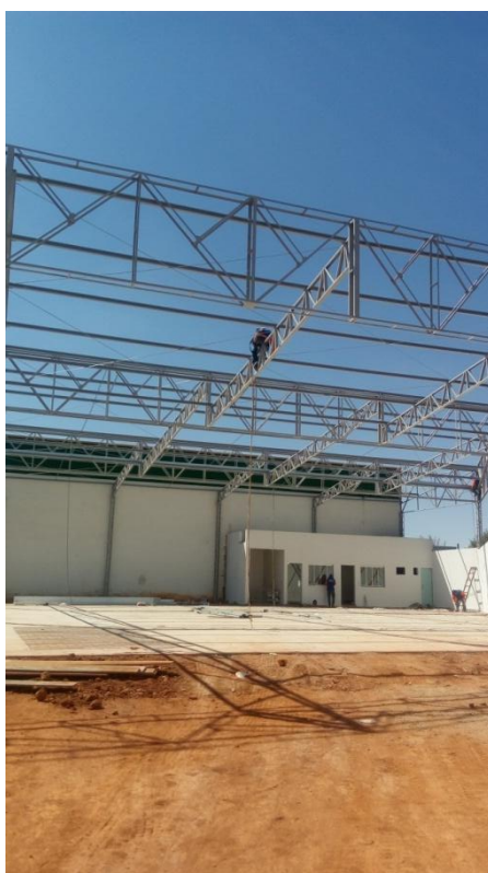
Figura5 - Construção civil comercial com estrutura metálica em Patos de Minas
