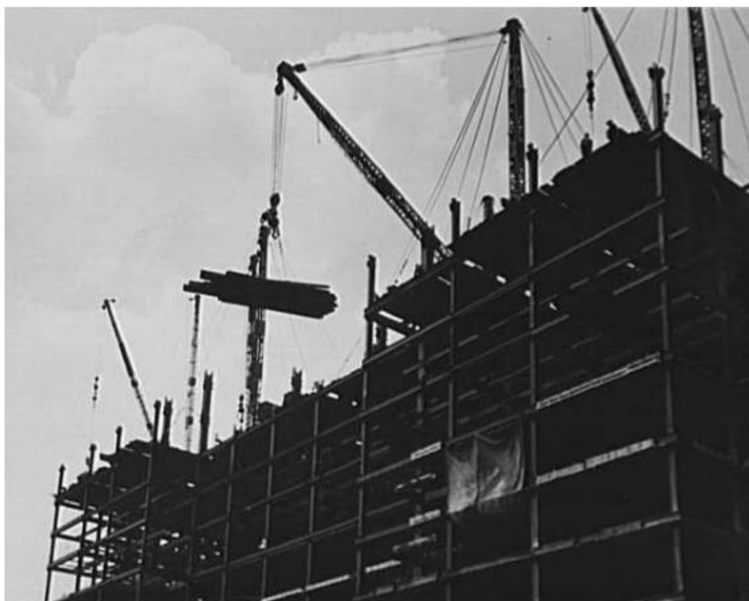
Figura 1 - Construção utilizando estruturas metálicas
