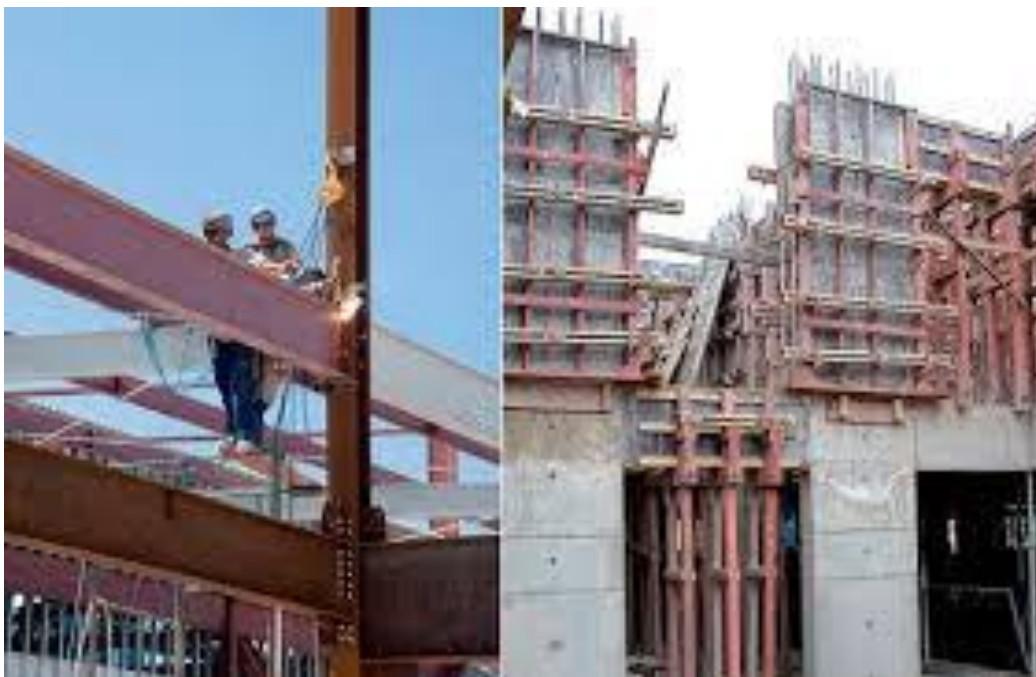
Figura 6 – Comparação de construção civil residencial em Patos de Minas
